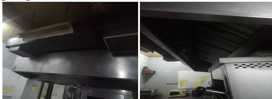
Gambar 9. Pembuangan Asap Kitchen Sumber: Dokumentasi Pribadi, 2021
