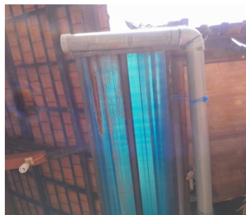
Gambar 3b. Tampak Talang Air Terpasang
