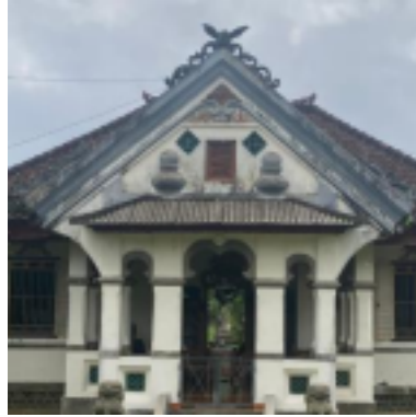
Foto 1. Gavel pada Bangunan Belanda Puri Agung Kerambitan Sumber: Dokumentasi pribadi, 2024
